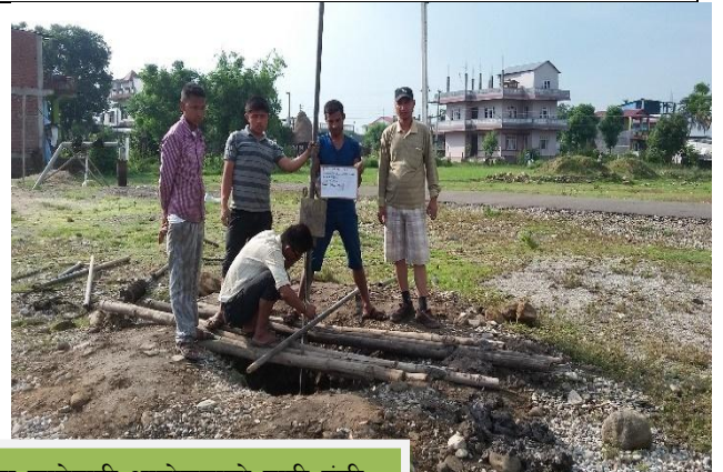
सह-लगानी कार्यक्रम अर्न्तगत धनगाडा खानेपानी आयोजनाको पानी टंकी निर्माणस्थलको माटो परिक्षण हुँदै
